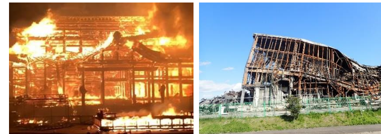
【R1.10月 沖縄県首里城火災 （那覇市消防局提供写真）】
