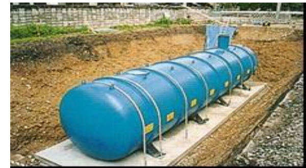
【耐震性貯水槽】
