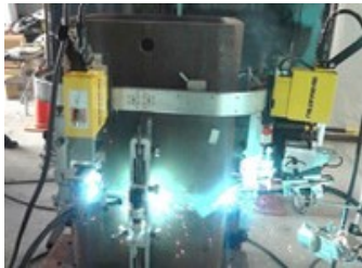
①建設ロボット
