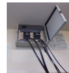
高い位置への配電盤設置
