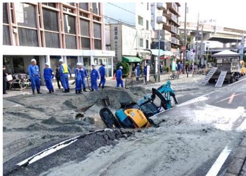
腐食に伴う水道管破裂による
