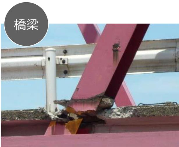
橋梁における鋼材の破断
