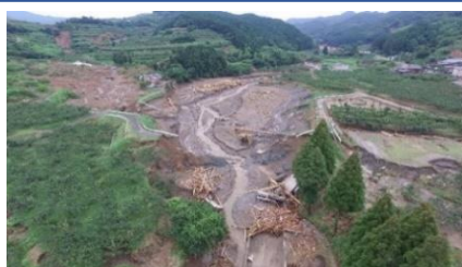
平成29年7月九州北部豪雨による河川と農地の被害状況
