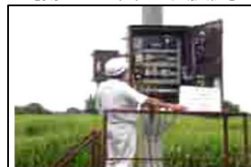
【揚水機の制御盤交換例】
