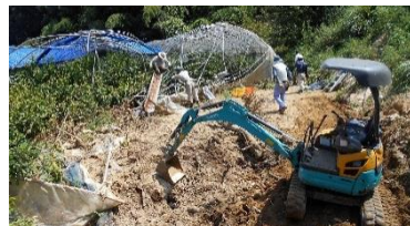
【直営施工方式による工事例】
