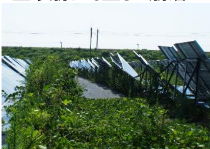
放置されたパネルの現況
