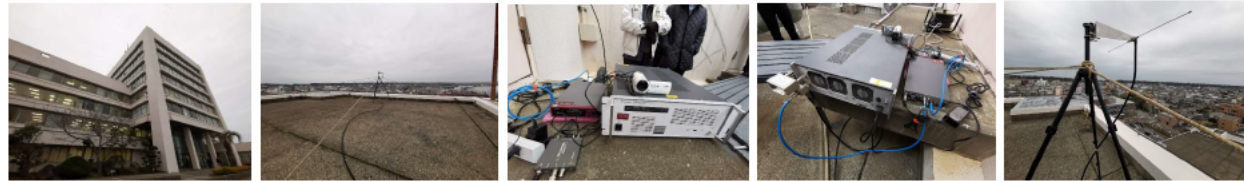
<純子市役所> <送信アンテナ全景> <送信設備:前面> <送信設備:背面> <市役所屋上で準備中>
