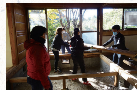
地域には改修しないと住めない空き家がたくさん。大工さんに教えてもらいながら空き家の床を張り直すワークショップを実施
