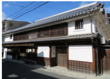
改修対象施設
