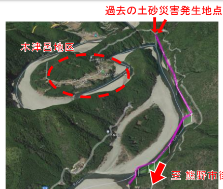
過去の土砂崩れの状況
