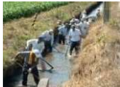
【水路の泥上げ】
