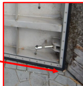
▲ゲート下部が地面に接触しており、スムーズに動かない。
