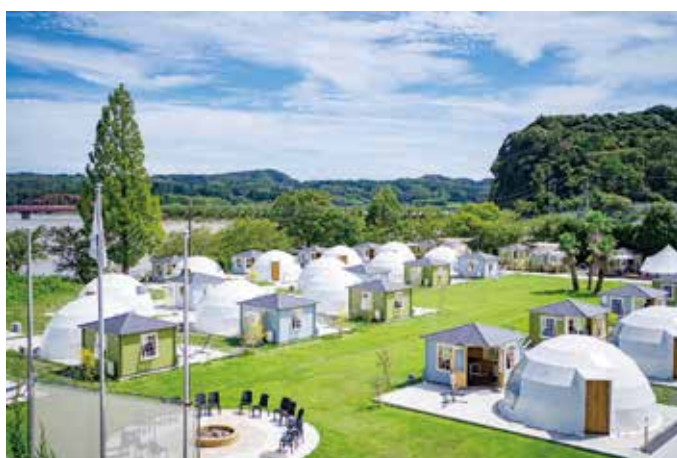
完成後のグランピング施設
