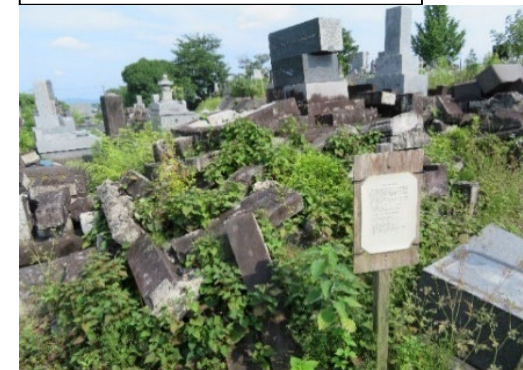
荒廃（被災後の未再建）
