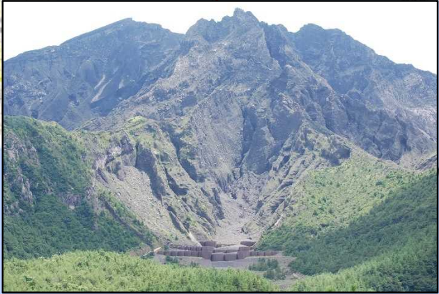
引の平沢地区荒廃及び復旧状況
