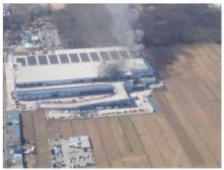
【平成29年2月埼玉県三芳町で発生した大規模物流倉庫火災】
