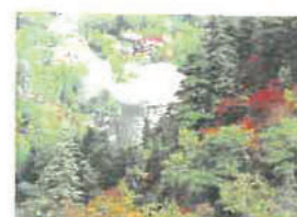
松川地熱発電所
