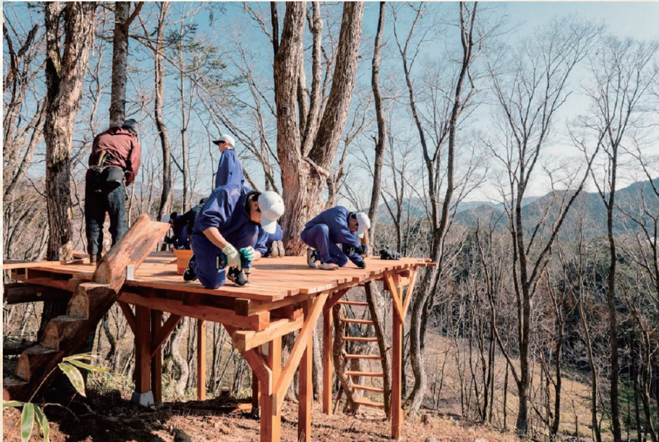
村の子供達と外部人材との協働により始まった「ハッピーマウンテン」づくり。外から見た村の魅力発信と、子供達の考えた新たな魅力づくりに地域が一体となって取り組んでいる。
