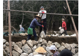
「岐阜の宝もの」にも選ばれた日本の原風景。高齢化により景観を維持できなくなった石積みヒダスケで延べ189人が参加し復旧した。
