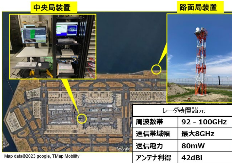
図 8 東京国際空港に構築した実証実験システム
