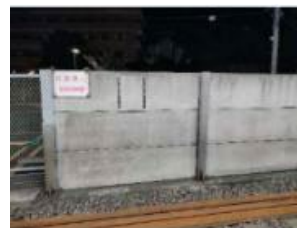
コンクリート壁
