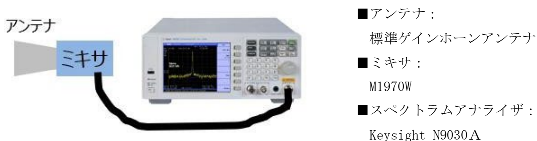
図6 漏洩電力測定設備
