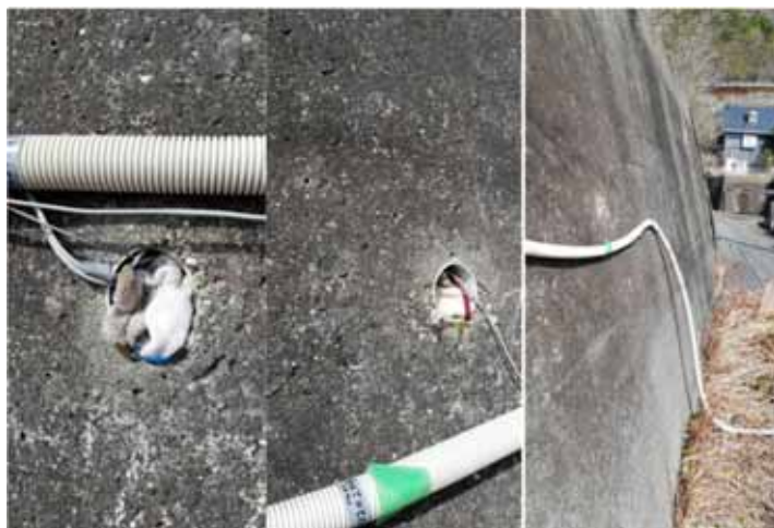
図 付録-2 擁壁の排水孔への電極の挿入
