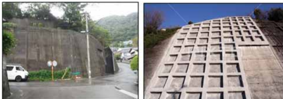
図 5-1 コンクリート擁壁の例
