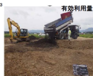
(乙) 農地整備工事
