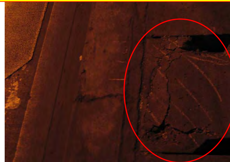
トンネル内の歩道にある側溝の蓋に長さ約20cmの破損
