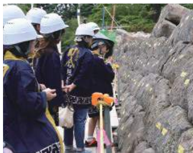
工事用足場を特別に歩き、解体が進む石垣を間近で見学
