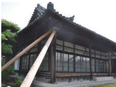
支柱で補強された「達磨寺方丈」
