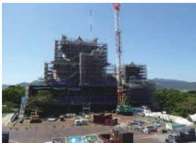
工事中の熊本城天守閣
