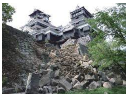
地震により崩落した熊本城の石垣
