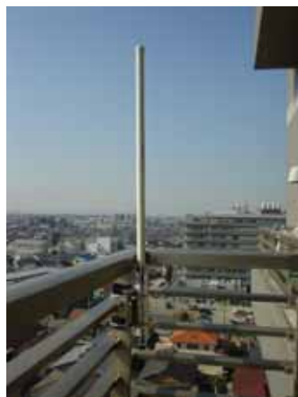
図 4.2. 84 アンテナ設置例
