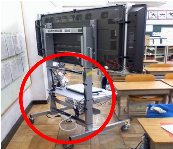
図 4-7 機器配線の整理
