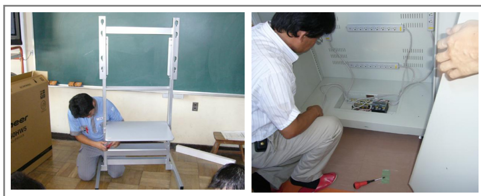
図 5-13 IWB・充電保管庫の組み立て作業
