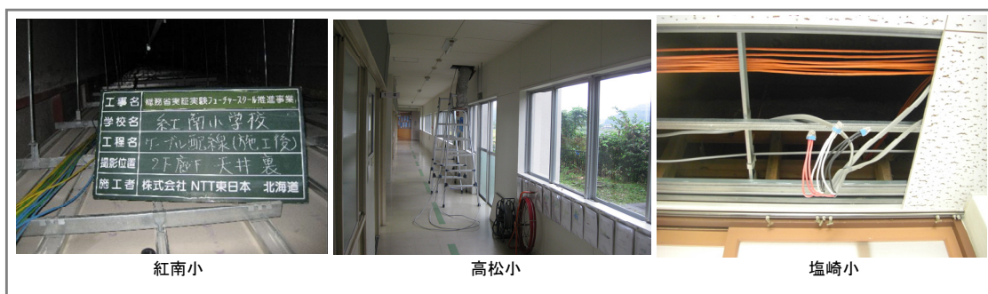
図 5-1 廊下天井裏の配線
