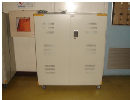
図 5-18 廊下の予備スペースに設置
