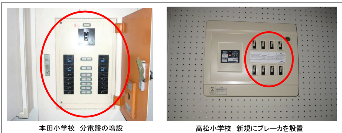
図 4-1 分電盤とブレーカの増設例
