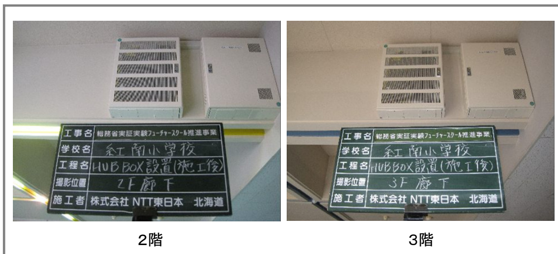
図 5-2 中継用 HUB ボックス
