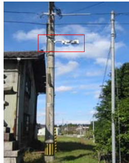
無線MAN/LAN中継装置設置状況
