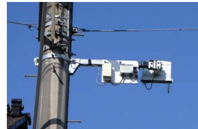
無線MAN/LAN中継装置設置状況(拡大)
