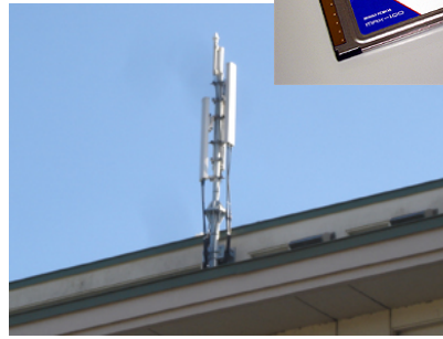
基地局アンテナ
