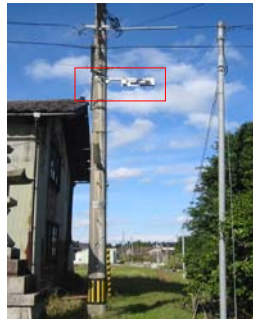
無線MAN/LAN中継装置設置状況
