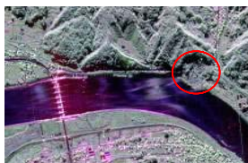
土砂崩れ現場のレーダー映像
