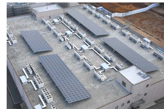
小山第2ネットワークセンター(150kW)
