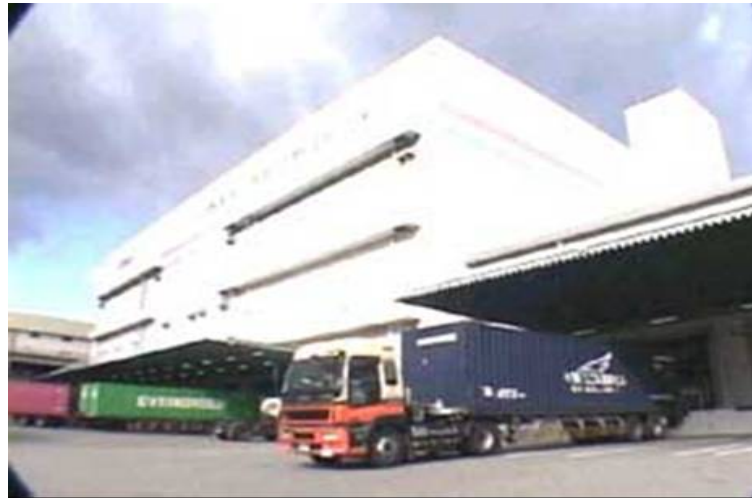
図4.2.6 配送センターの概観
