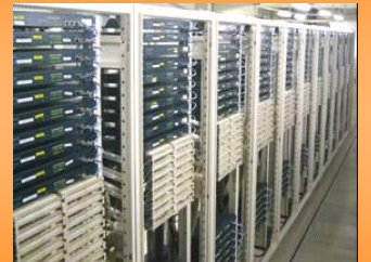
他社のIP系設備の例 【ADSL装置】
