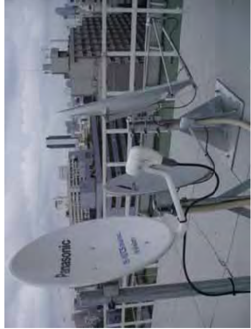
図 36 受信用 45cm 径 パラボラアンテナ
