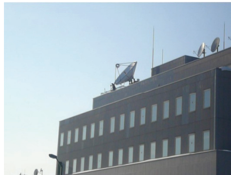
1番基地局 5階建ビル屋上
