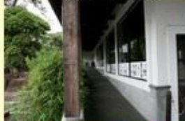
駐車場から建物までの屋根
