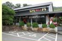
駐車場の仕上げ
