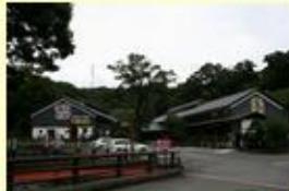
駐車場から建物までの屋根
