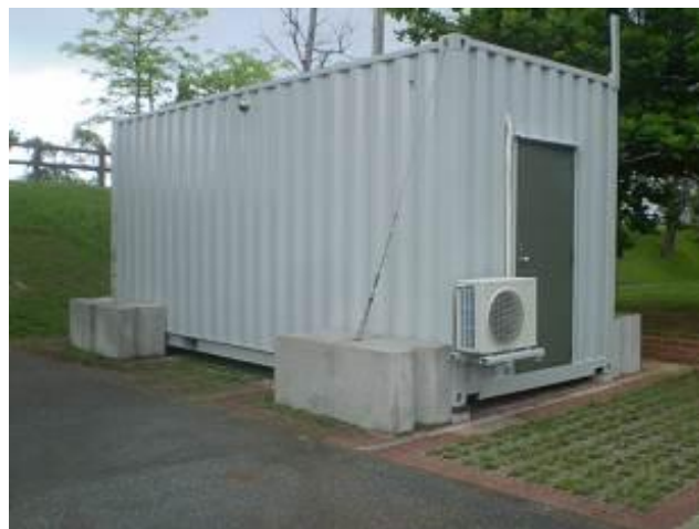
設置完了した植物工場の外観
