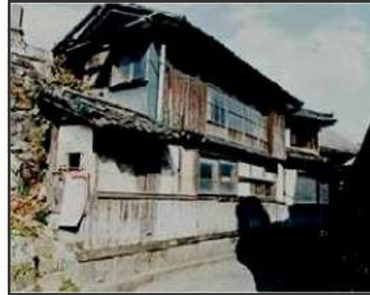
廃屋になっていた寺院
