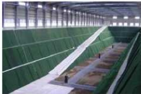
最終処分場内部
