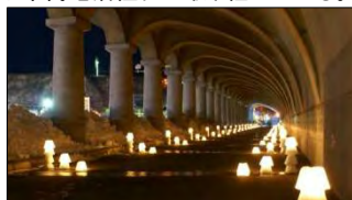
北防波堤ドーム：(S11完成)ギリシア建築様の円柱とアーチ屋根を持つ防波堤(北海道土木遺産)
