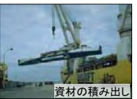
資材の積み出し
