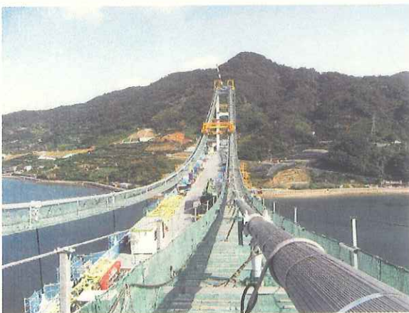
広島県呉市 豊島(離島架橋整備) ※H20.11.18豊島大橋開通
