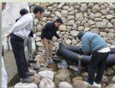
砂防ダム河川水位計の 設置・実証 (和歌山県那智勝浦町)
