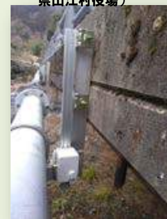
河川水位計の設置・実証 (熊本県山江村)
