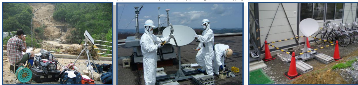
図表 2-1-9 衛星回線の復旧活動事例
