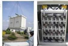
(バッテリー収容箱) (バッテリー)
