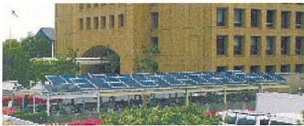
県庁に設置された太陽光パネル = 県提供
