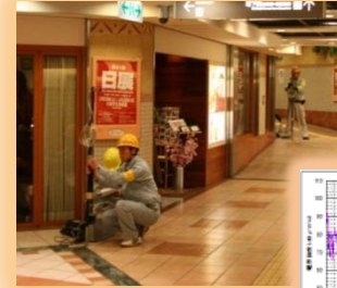
電波状況の調査
