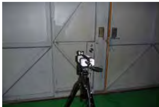
屋内から見た鉄扉
